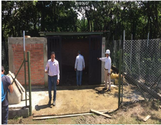
Adecuación y ampliación de la caseta
