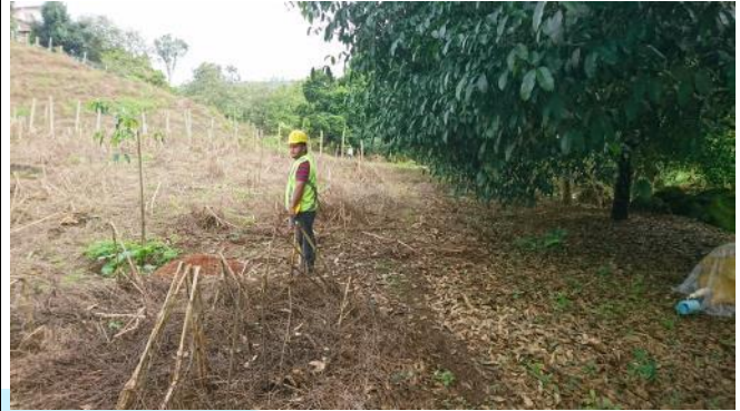
Replanteo en terreno de línea de aducción. FECHA: 10/05/2018
