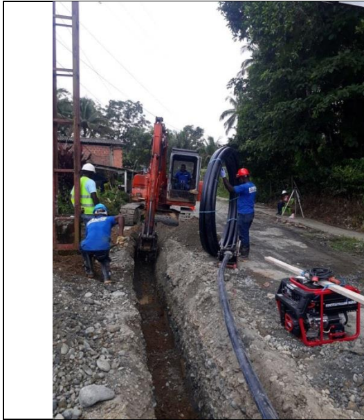
Instalación de tubería, centro poblado de Córdoba - Buenaventura
