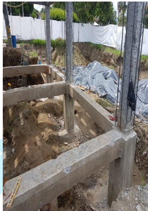
ALMACENAMIENTO DEL MATERIAL EXCAVADO Y ALMACENAMIENTO DE MATERIALES DE CONSTRUCCION
