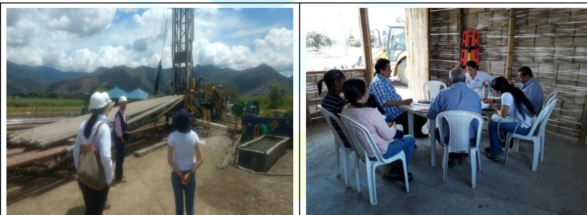
COMITÉ INTERINSTITUCIONAL Y RECORRIDO DE OBRA CON REPRESENTANTES DE VALLECAUCANA DE AGUAS, ALCALDÍA, CONTRATISTA E INTERVENTORÍA
